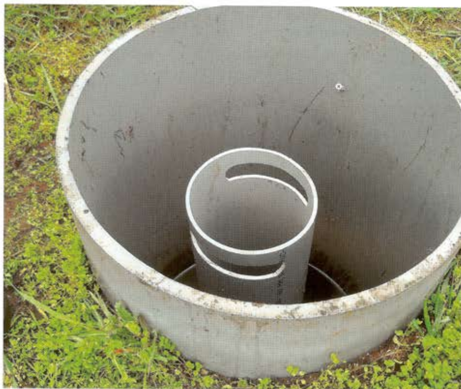
Peilgestuurde drainage in stedelijk gebied maakt sturing van het grondwaterpeil, tot op zekere hoogte, mogelijk. De foto toont het 'hart van het systeem, dat bestaat uit een stuwput met twee uitmondingsbuizen, waarvan de hoogte en daarmee de ontwateringsdiepte instelbaar is: geen vast, maar een variabel (instelbaar) drainage- of ontwateringspeil.
