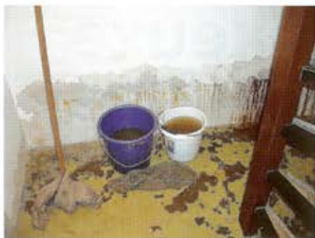
Effect van een stijgend grondwaterpeil op kelders (de hoogte van het grondwaterpeil aan de buitenzijde van de kelder is bij benadering af te lezen aan de rand met oranje verkleuringen aan de binnenzijde).
